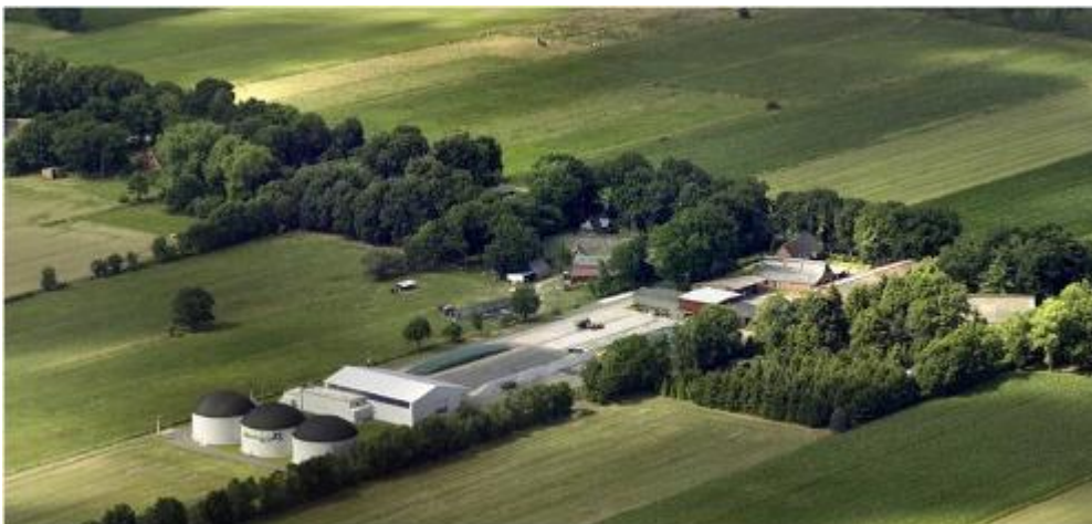
Figuur 8 Luchtfoto: 1,000 kWe covergistingsinstallatie met één propstroomvergister.
