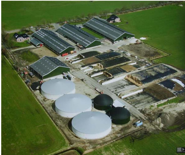
Luchtfoto 1 MW e covergistingsinstallatie . De drie witte silo's zijn voor mestopslag, de twee zwarte zijn 0,5 MW e vergisters
