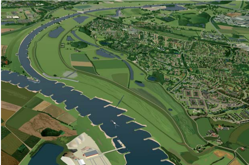
FIGUUR 1.3A + 1.3B Ruimte voor de rivier: De Hondsbroeksche Pleij bij Westervoort is een voormalige uiterwaard op de oever van de Neder-Rijn en de IJssel. De dijk wordt verlegd, waardoor het rivierwater (boven weergegeven bij normale waterstand) wijd uit kan stromen bij hoog water (onder).
