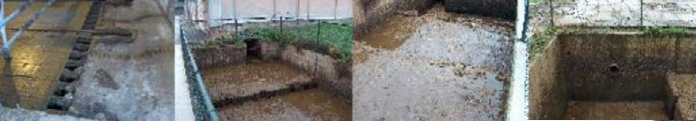
foto's: Bezinkbassin Melkveebedrijf Schep; mest/zand afvoer stal, toevoer bassin, bassin, overloop, verdunde mestopslag
